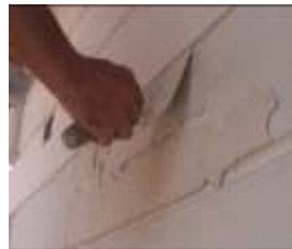
Nakładanie tynku
