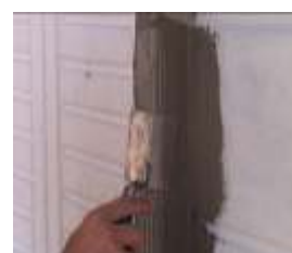
Zbrojenie i profilowanie okiennic i dekoracji
